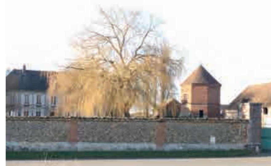
Mur ancien en pierres à silex et briques rouges vieilles et pigeonnier de la ferme.
