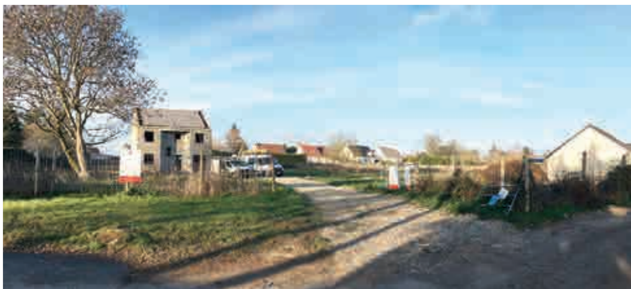
Au nord de la rue du Four à Chaux, habitations individuelles récemment réalisées ou en cours de construction.
