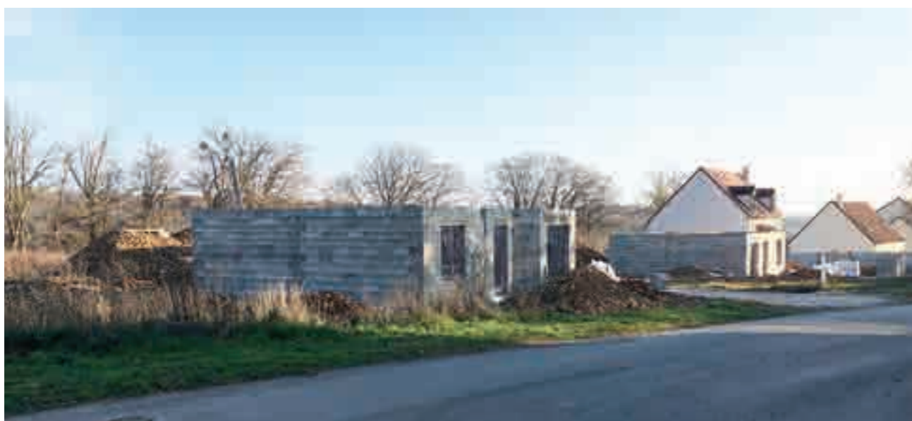
Site de l'ancienne ferme rue du Four à Chaux, habitations individuelles en cours de construction.
