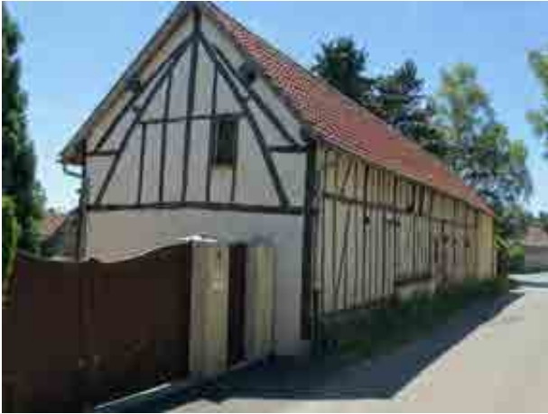
Construction à ossature bois apparente
