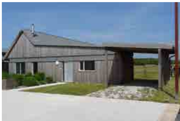
Habitation contemporaine accompagnée d'un abri ouvert (Paluel) CoBe Architecture & Mutabilis
