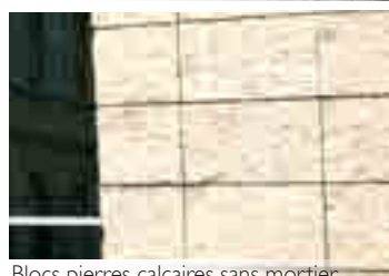
Blocs pierres calcaires sans mortier
