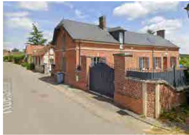
Mur et piliers en brique
