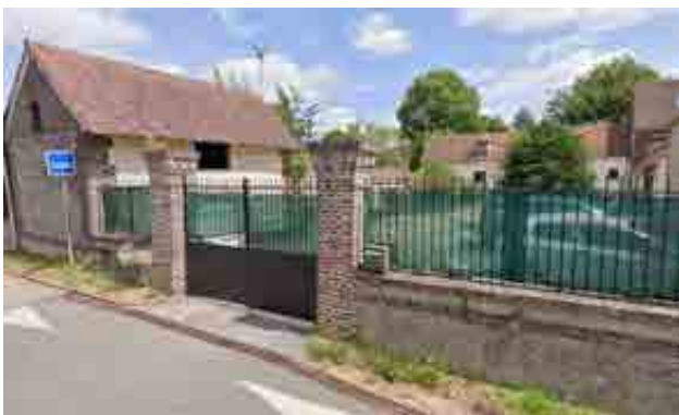
Muret et pilier en brique et pierre
