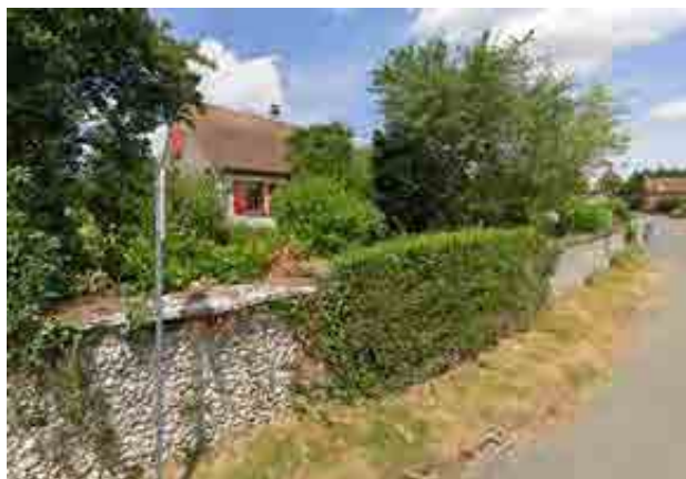
Mur en pierres
