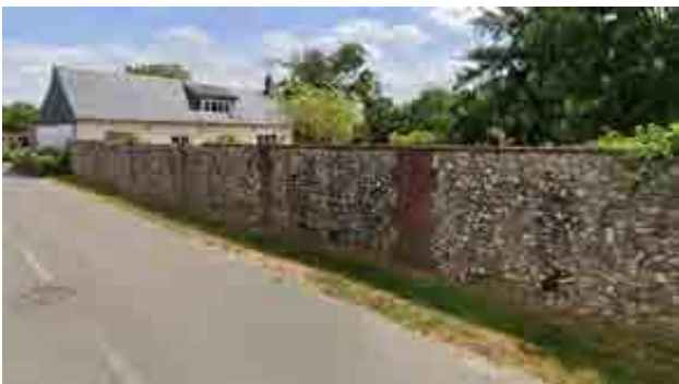
Mur en pierres et briques
