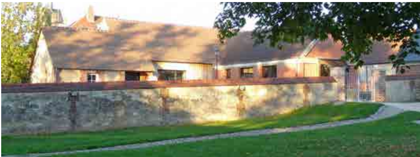
Mur composite (briques et moellons) clôturant un espace public (Fresnes-l'Eguillon)
