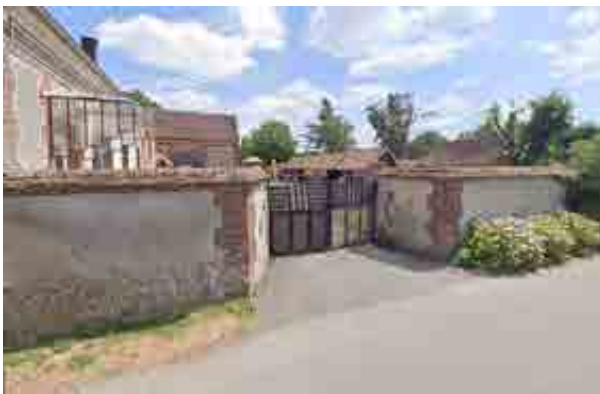
Mur en pierre et brique
