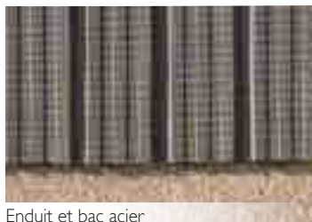
Enduit et bac acier
