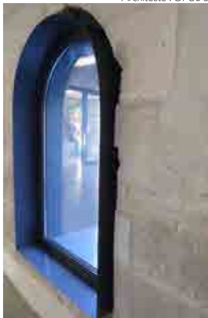
Réhabilitation d'une baie d'un mur de pierre (Louviers)
