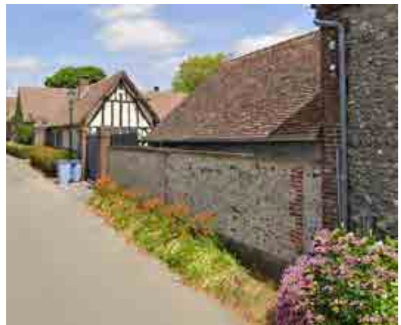
Mur en pierre et pignon à ossature bois
