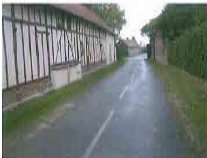
Voirie rue du Four à Chaux
