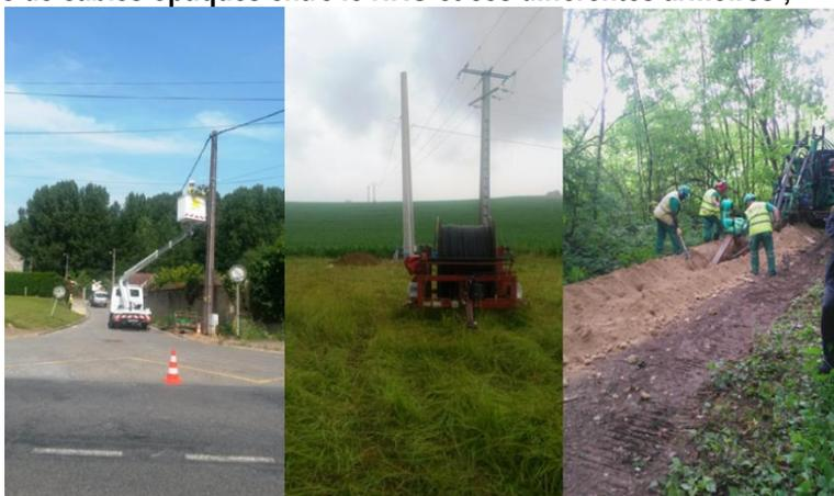
Déploiement de la fibre optique : utilisation des infrastructures existantes, réalisation de génie civil.
