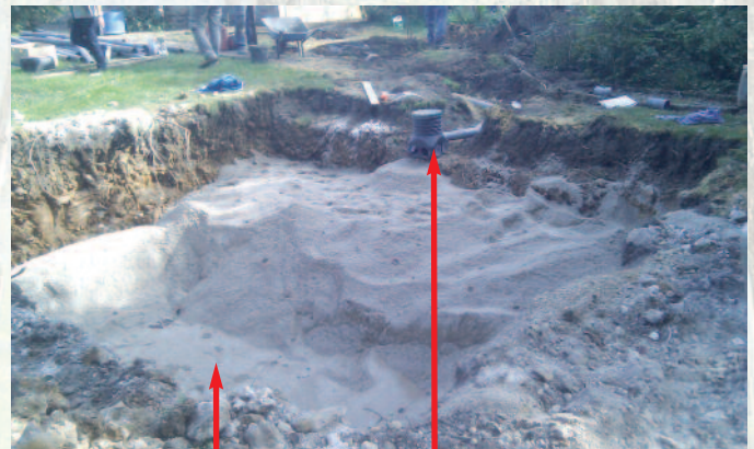
Mise en place du sable filtrant
