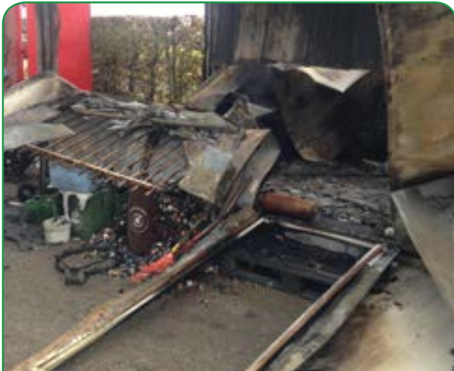
Le local du gardien et les filières piles et capsules à café après l'incendie
