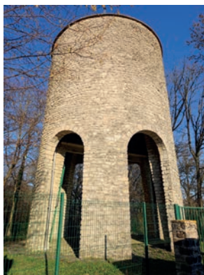
CHÂTEAU D'EAU DE LÈVEMONT
